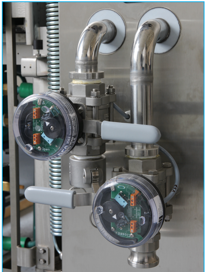
Připojení generátoru zdroje H 2 O 2
